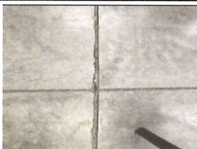
Foto 3: PISO Sustrucción de piso de concreto con acabado liso por piso cerámico, incluyendo preparación de superficie y nivelación. Aula
