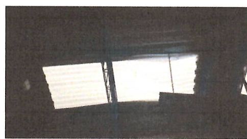
Foto 2: CUBIERTA DE LAMINA Sustrucción de cubierta de techo con lámina galvanizada, Tipo de lámina: troquelada Calibre: 26, incluye: fijaciones y sellado en traslapes.
