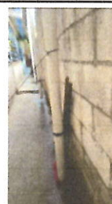
Foto 4: CANALES Y BAJADAS DE AGUA PLUVIAL Sustrucción de bajantes para evacuación de aguas pluviales anclada por medio de abrazaderas y tornillos
