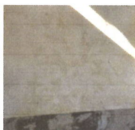
Foto 5: REPARACIÓN DE REPELO Y CERNIDO DE PAREDES Reparación de repello y cernido en muro de mampostería con aplicación de acabado uniforme. Muro interiores de aula
