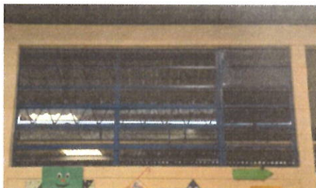
Foto 1: VENTANAS Sustrucción de ventanas; sistema de apertura: Corredizas, Perfiles color blanco estandar, Material del marco: PVC Material de la ventana: Vidrio, sellado perimetral. Aula
